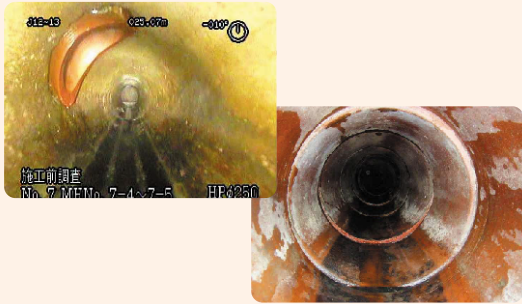
施工前の管内
