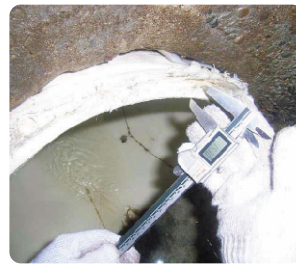
施工後の厚み測定
