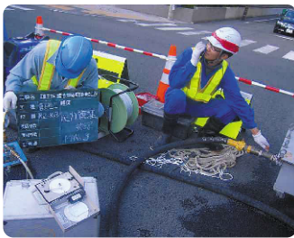
施工中の圧力管理
