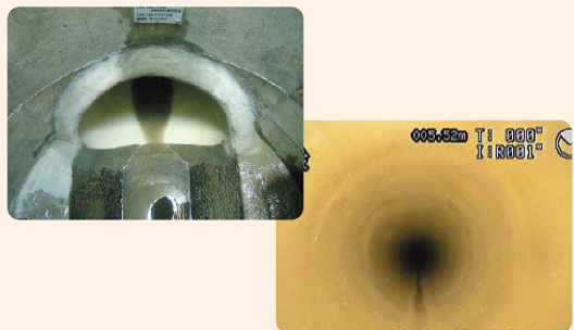
施工後の管内
