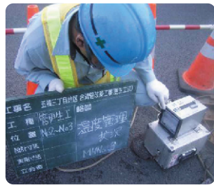
施工中の温度管理
