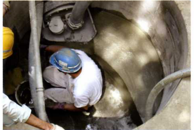
割込人孔設置に伴う水替状況
