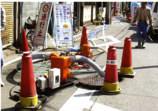
市街地での水替状況
