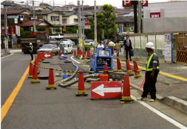
工事区画状況
