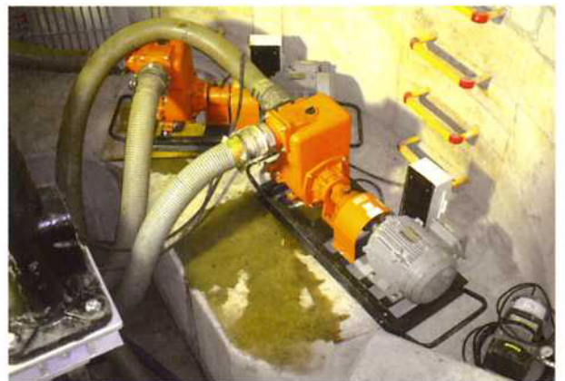
管渠移設に伴う水替状況（中間スラブ）
